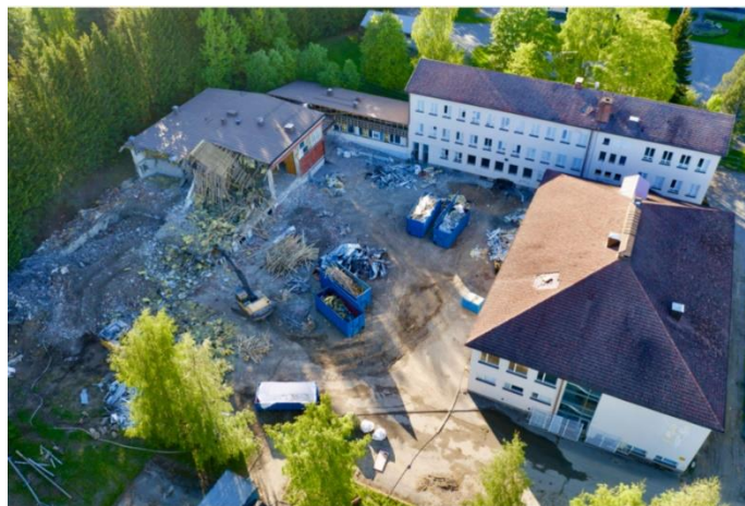
Kummun koulun purkutyömaa. Kuva Jari Turpeinen
